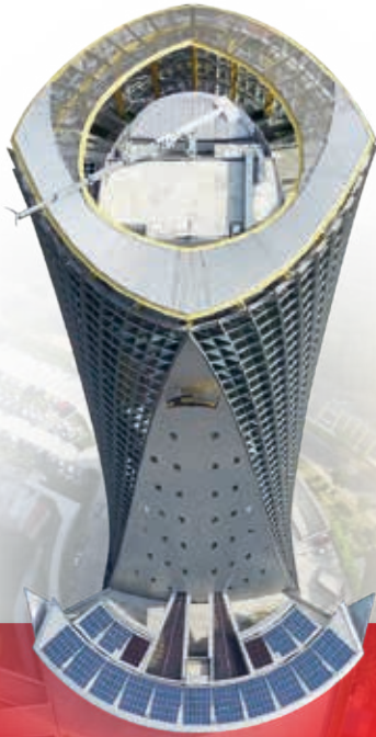
Kompleks Kerja Raya 2 (KKR2), - 108kWp
